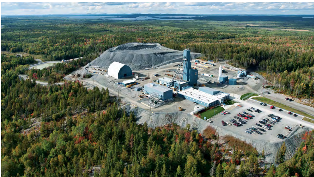
Les activités de remise en état à la mine Lapa ont commencé en 2019 et prendront fin en 2020.
