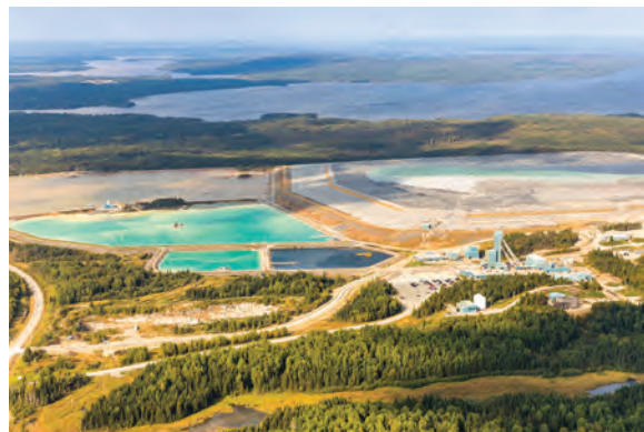
Installation de stockage des résidus au Complexe minier LaRonde.
