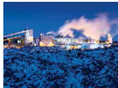
Kittilän kaivos on vuodesta 2014 lähtien kierrättänyt rikastamolta ja prosesseista kerättyä hukkalämpöä, millä pienennetään kaivoksen yleistä energiantarvetta ja kustannuksia.
