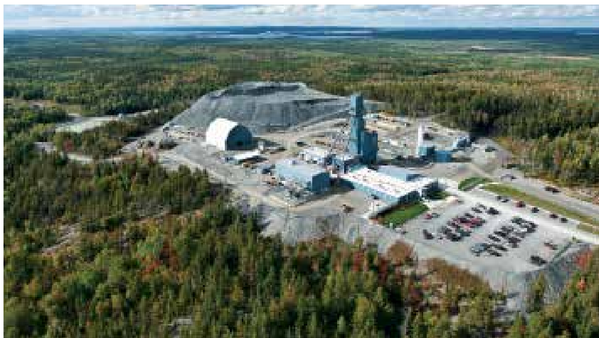
Lapan kaivoksen kunnostustyöt jatkuivat vuonna 2019, ja ne saadaan päätökseen vuoden 2020 aikana.
